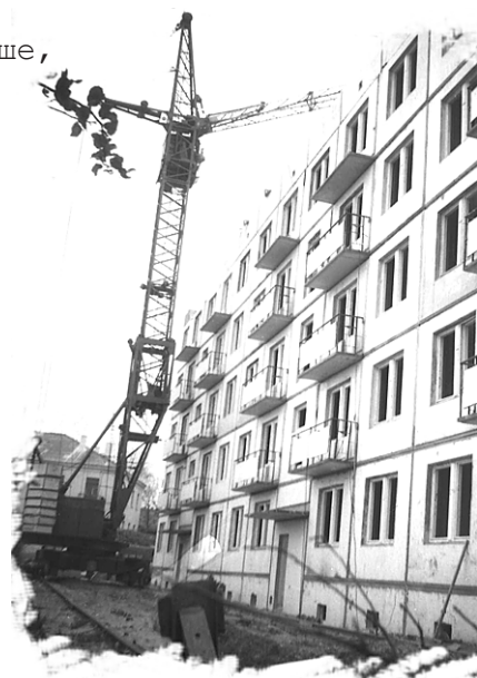
Монтаж панельного дома
